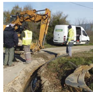
Communauté d'Agglomération du Pays d'Aix, Chantier THD, décembre 2009
